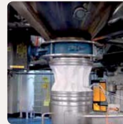
Manchette positionnée sous vanne papillon avec tenue au vide
