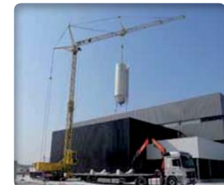
Grutage et installation sur votre site
